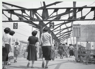
工事中の西武新宿駅ホーム (昭和20年代後半)
