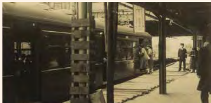
木製ホームに段差があり、足下注意の表示がある。
