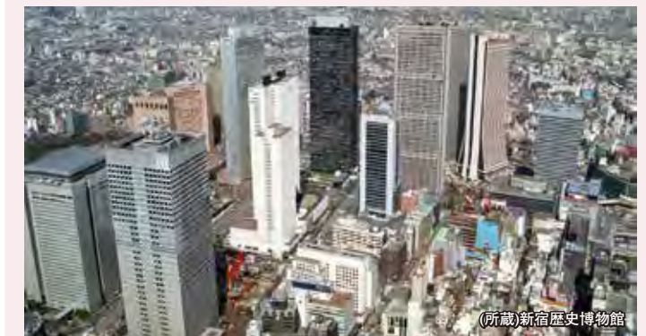
建設中の都庁舎(平成元年)
